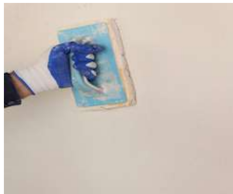
Φινίρισμα της επιφάνειας του Intomarp Mono.
