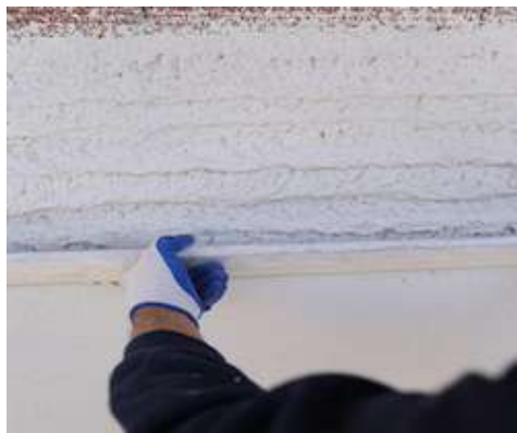
Διάστρωση με πηγή
