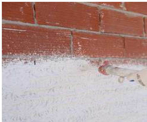
Εφαρμογή Intomarp Mono με μηχανή κονιαμάτων
