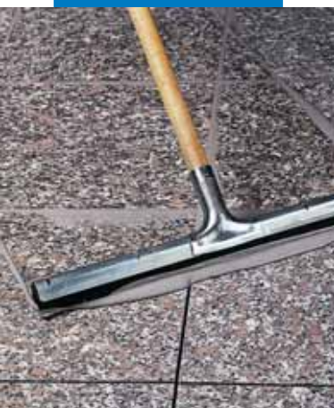
Αρμολόγηση δαπέδου από προγαλισμένο γρανίτη με λαστιχένια σκούπα
