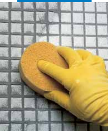
Φινίρισμα αρμολόγησης υαλοψηφίδας με σφουγγάρι
