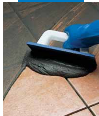
Αρμολόγηση μονόπυρου πλακιδίου με σπάτουλα
