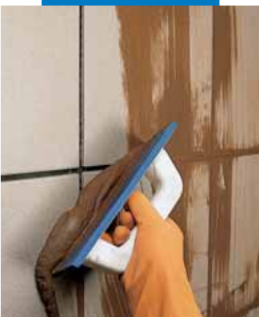
Αρμολόγηση εξωτερικού τοίχου με σπάτουλα
