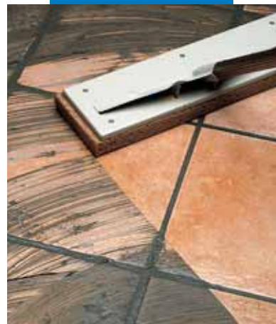
Καθαρισμός δαπέδου από μονόπυρα πλακίδια με σκούπα-σφουγγάρι
