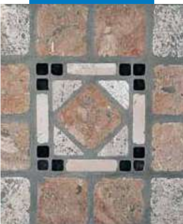
Παράδειγμα αρμολόγησης πλακιδίων από παλαιωμένο μάρμαρο
