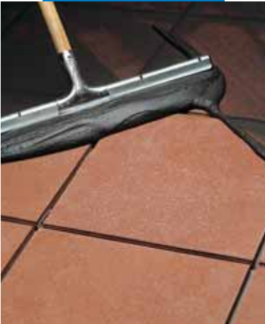
Αρμολόγηση πλακιδίου τερακότα με λαστιχένια σκούπα
