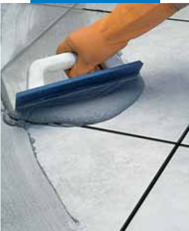
Αρμολόγηση κεραμικού πλακιδίου δαπέδου με σπάτουλα
