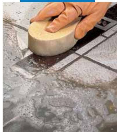
Φινιρίσμα δαπέδου με κεραμικά πλακίδια και εμφυτεύματα ξύλου με σφουγγάρι
