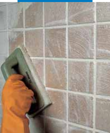
Φινιρίσμα σε τοίχο με μονόπυρο πλακίδιο με σφουγγάρι Scotch-Brite®
