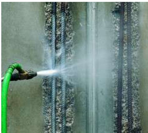
Καθαρισμός ράβδων οπλισμού
