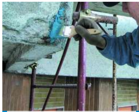
Εφαρμογή του Mapefer 1K με βούρτσα σε ράβδους οπλισμού μπαλκονιού από οπλισμένο σκυρόδεμα
